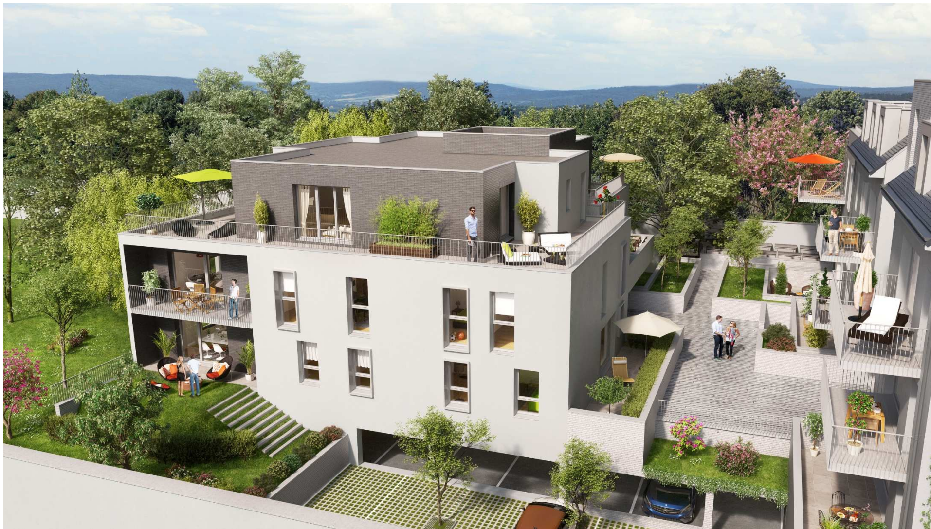
Bâtiment cœur d'îlot
